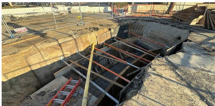
Continúan los trabajos en el sistema subterráneo de concreto de drenaje pluvial en Felspar Street. Un carril de circulación está abierto en cada dirección.
