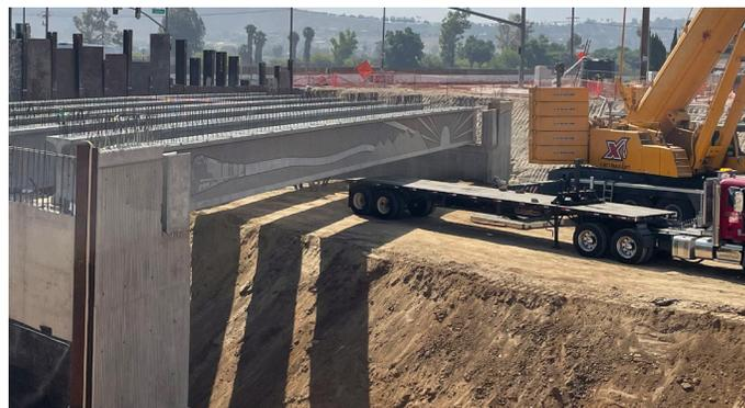
Un equipo de diez personas recibió e instaló seis vigas de 120 pies de largo que pesaban 170,000 libras cada una. Se utilizó una grúa de 500 toneladas para mover e instalar cada viga. Habrá un total de 12 vigas utilizadas para construir el puente de Van Buren Boulevard.
