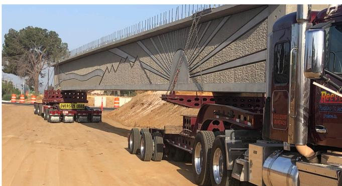
Las cuadrillas entregaron e instalaron la viga decorativa, o la viga de soporte para la estructura del puente, en el lado norte del puente Van Buren Blvd.
