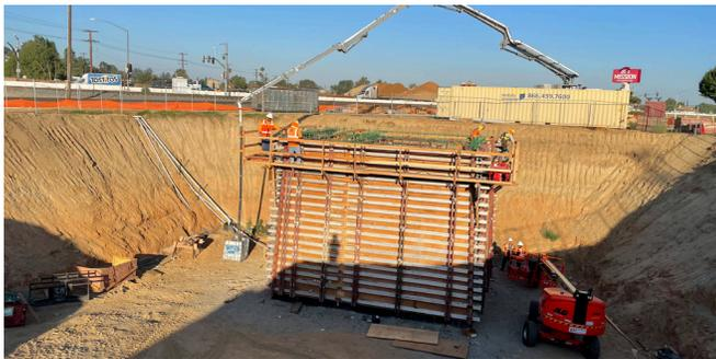
Se colocaron casi 276 yardas cúbicas de concreto para las paredes del pozo profundo de la estación de bombeo de aguas pluviales. Cuando estén terminados, estos muros de hormigón se extenderán 40 pies bajo tierra.
