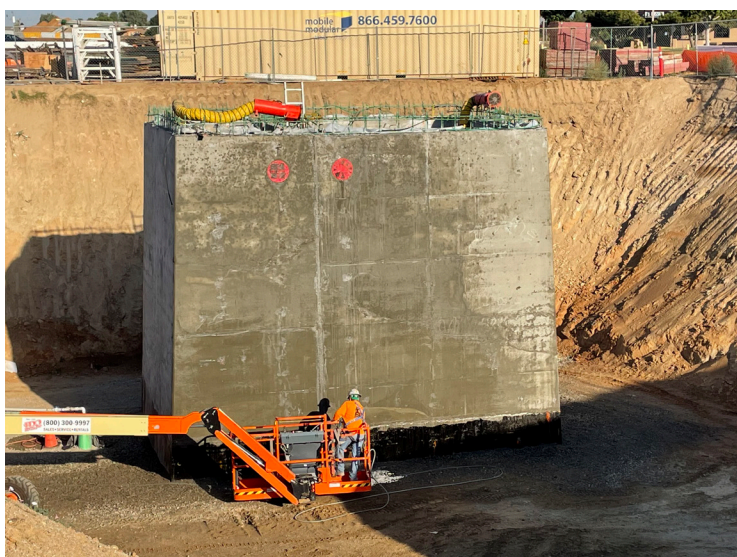
Las cuadrillas rellenarán la estación de bombeo de aguas pluviales esta semana. La segunda foto muestra a las cuadrillas instalando una barrera impermeabilizante. Una vez completada, esta estructura tendrá 45 pies de altura, en su mayoría bajo tierra.
