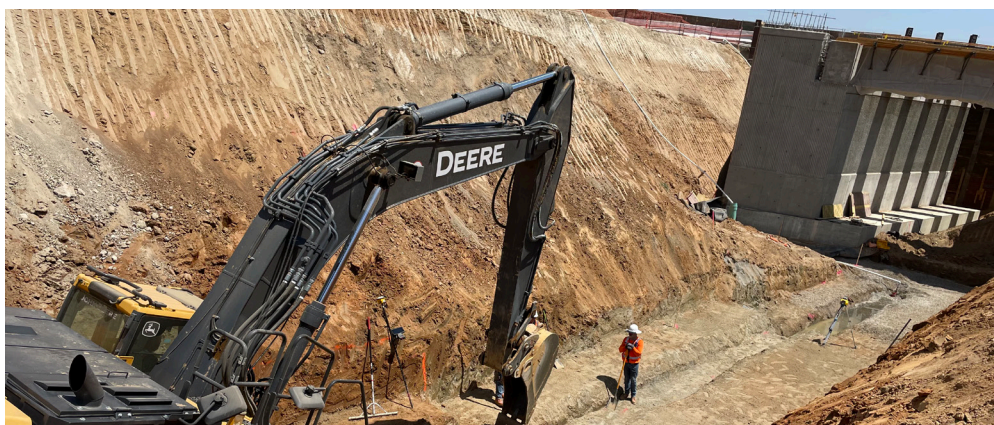
Las cuadrillas rellenarán la estación de bombeo de aguas pluviales esta semana. La segunda foto muestra a las cuadrillas instalando una barrera impermeabilizante. Una vez completada, esta estructura tendrá 45 pies de altura, en su mayoría bajo tierra.
