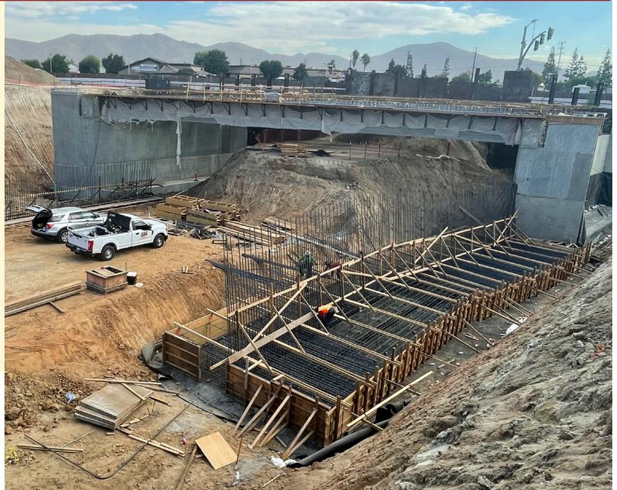
Una mirada "detrás del riel de protección (k)" a la construcción en los cimientos de la pared donde las cuadrillas colocarán casi 500 yardas cúbicas de concreto el miércoles por la mañana temprano.
