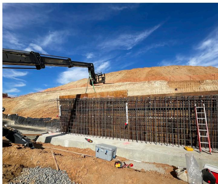
Las cuadrillas trabajando en los sistemas de soporte del muro de contención para el paso subterráneo de Jurupa Road.
