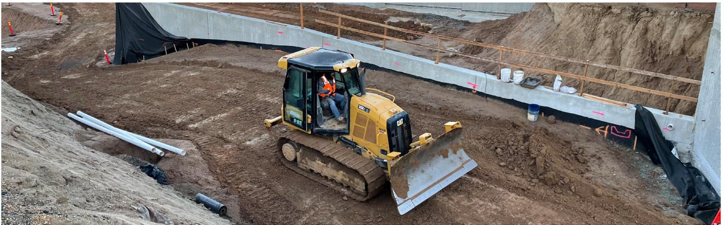
**Las cuadrillas haciendo labores de relleno en el sistema de muro de contención de paso subterráneo de Jurupa Rd.**
