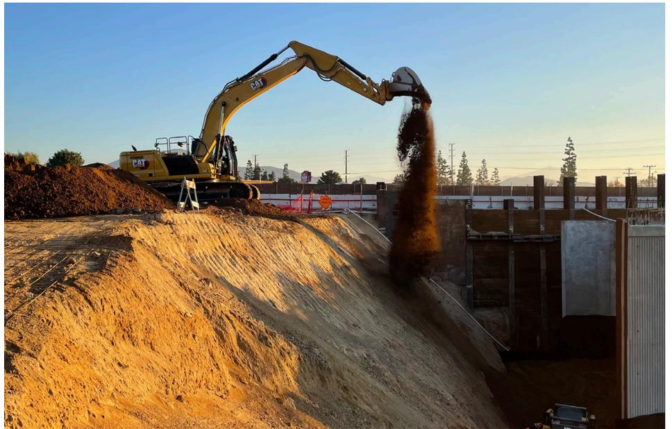
Mirando hacia el este, las cuadrillas están rellenoando el extremo norte del sistema de soporte del puente de Van Buren Boulevard.
