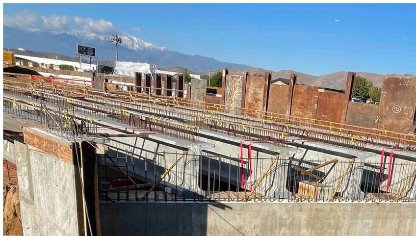
Una vista hacia el norte del muro de contención y el sistema de soporte del puente en Van Buren Boulevard. Una vez terminados éstos, el siguiente paso será construir la plataforma del puente
